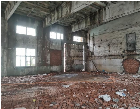
图4：现场西南墙改梁部位
