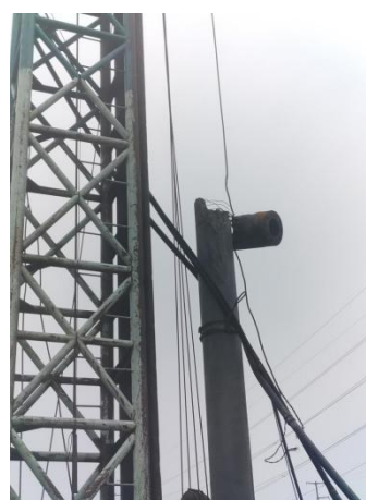
图4：预应力管桩头部
