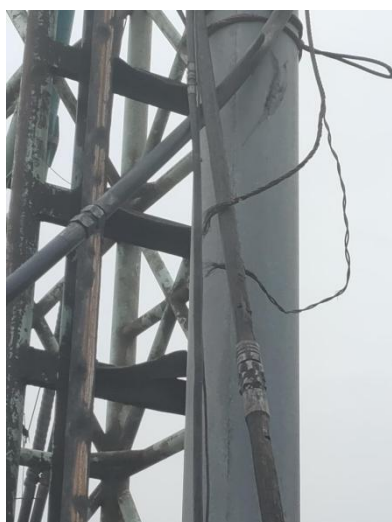
图5：装机钢丝断裂位置
