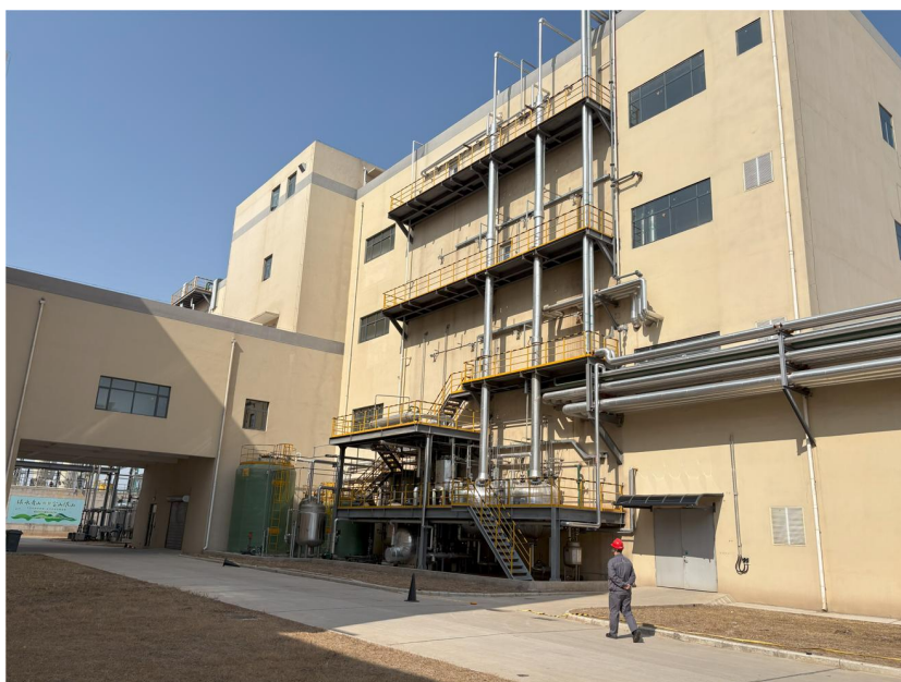
图 1.3-1 事故车间概貌
