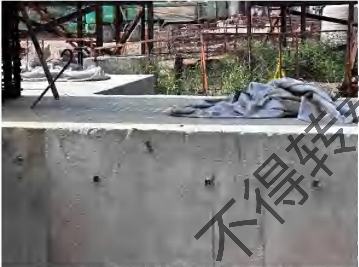
图 3: 42#墩承台与涉事模板连接处撬痕
