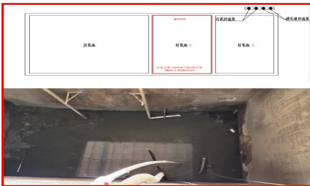
图 2 事故池（好氧池 1）
