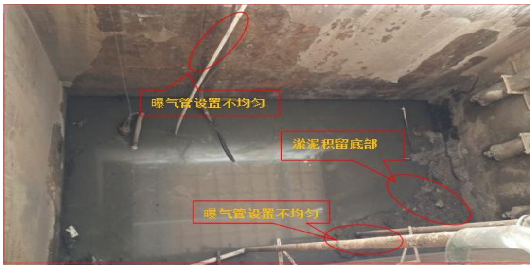
图 5 污水曝气管分布不均示意图
