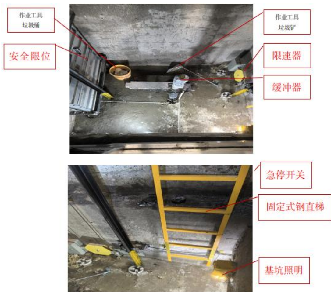
图 1 事故现场照片
