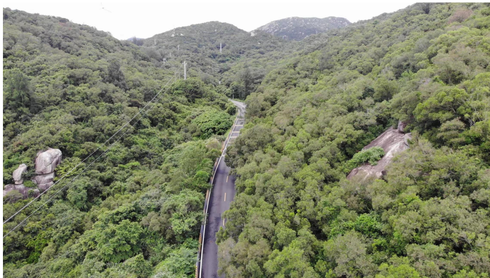
图 3 事故路段全景
