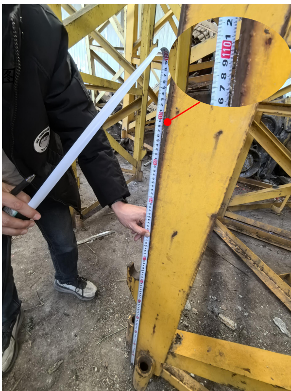
图 3 B 组钢材高 1.07 米处碰撞痕迹照片
