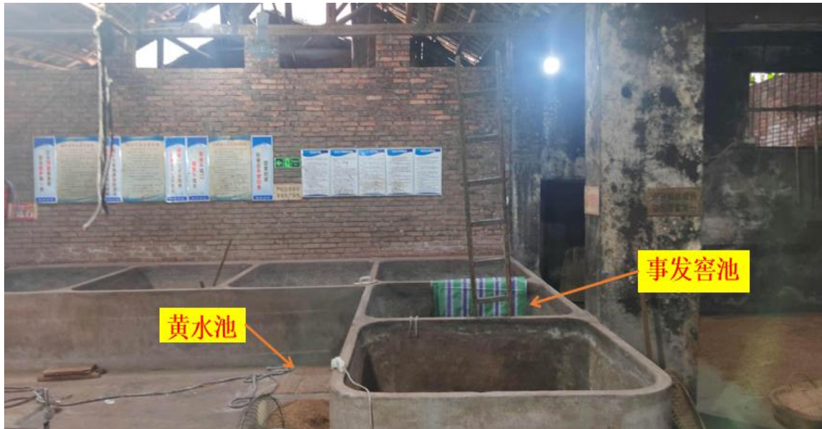
图 2 窖池布局现场图
