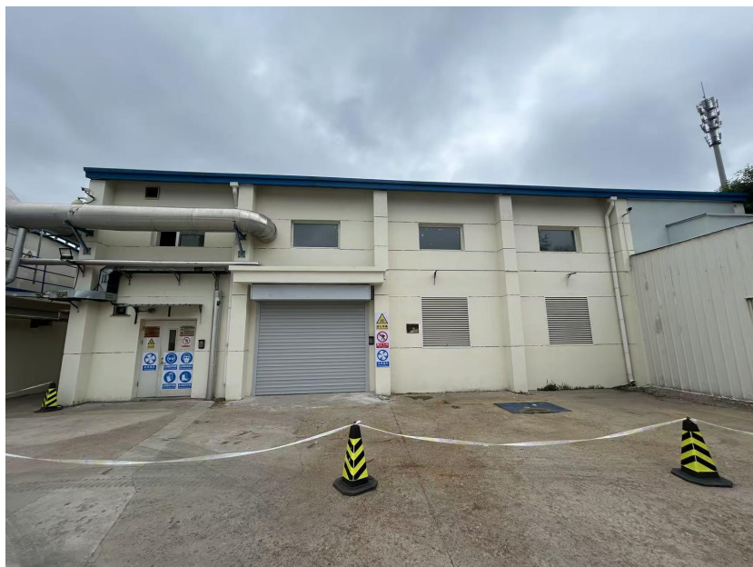
压滤机房外观
