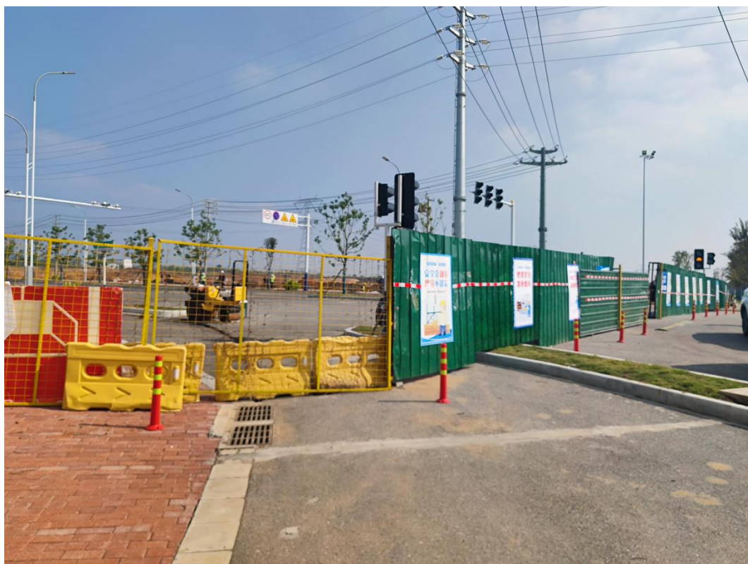
图 2 评估组抽查在建市政道路施工工地
