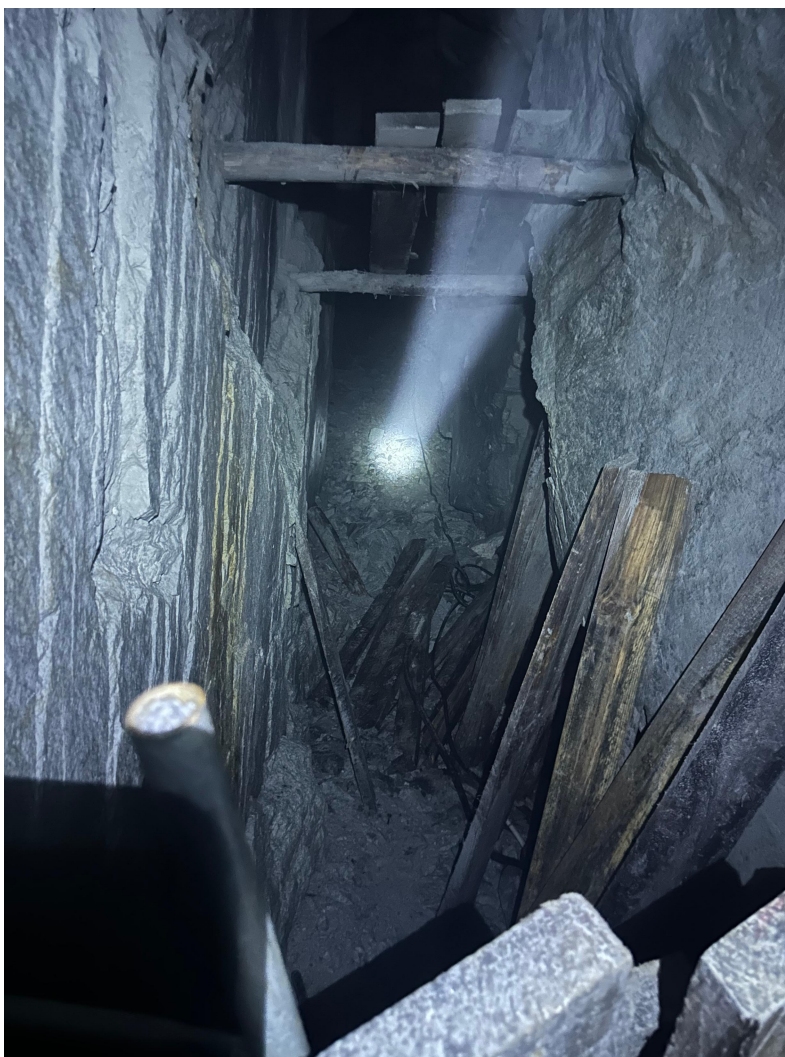
图 1 现场勘察照片
