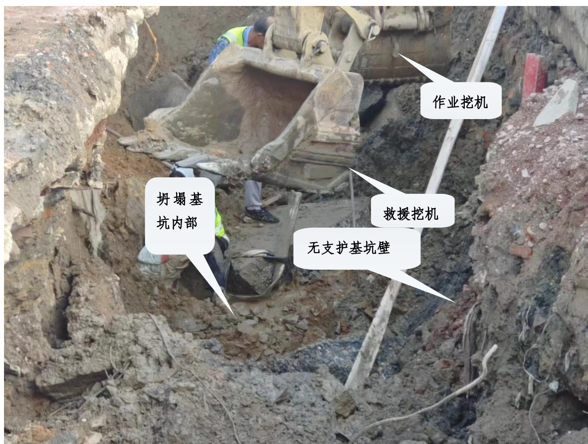
图 1 现场勘察情况
