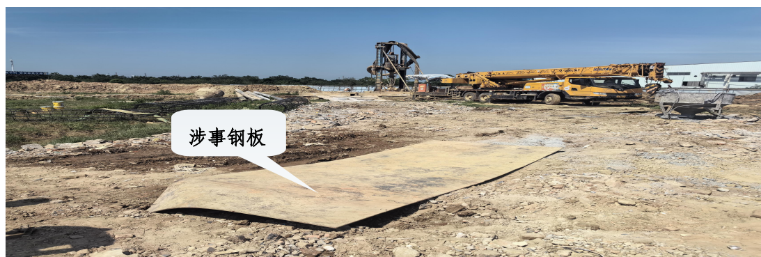
图1 现场勘查情况
