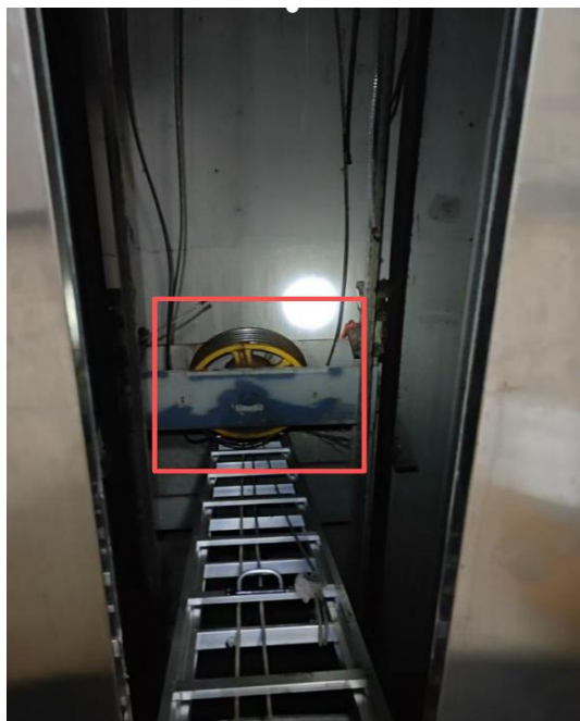
图 1 维修平台搭建后的图片
