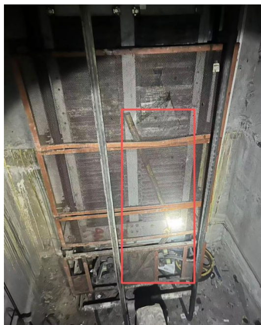
图 2 用于支撑对重的钢管
