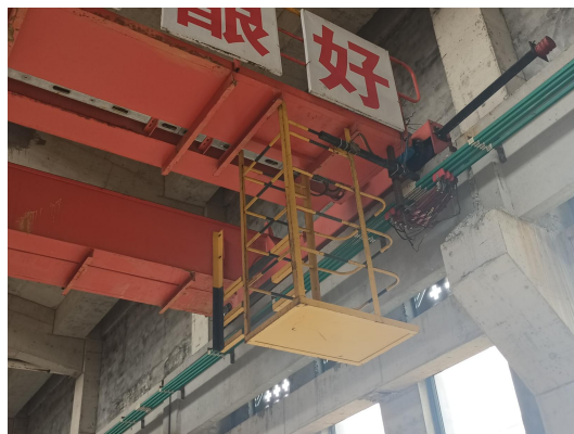
图 2 事故地点所在检修吊篮
