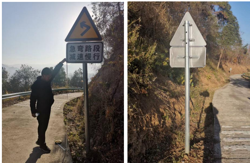
图 2 事故路段警告标志设置情况
