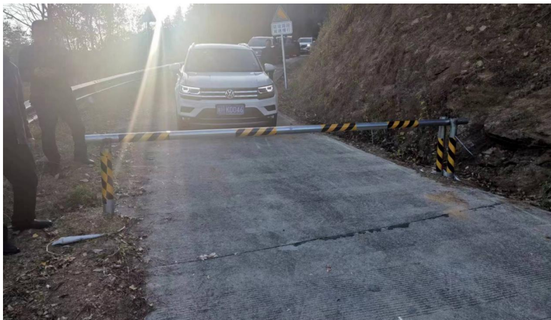
图 3 事故路段入口增设的栏杆
