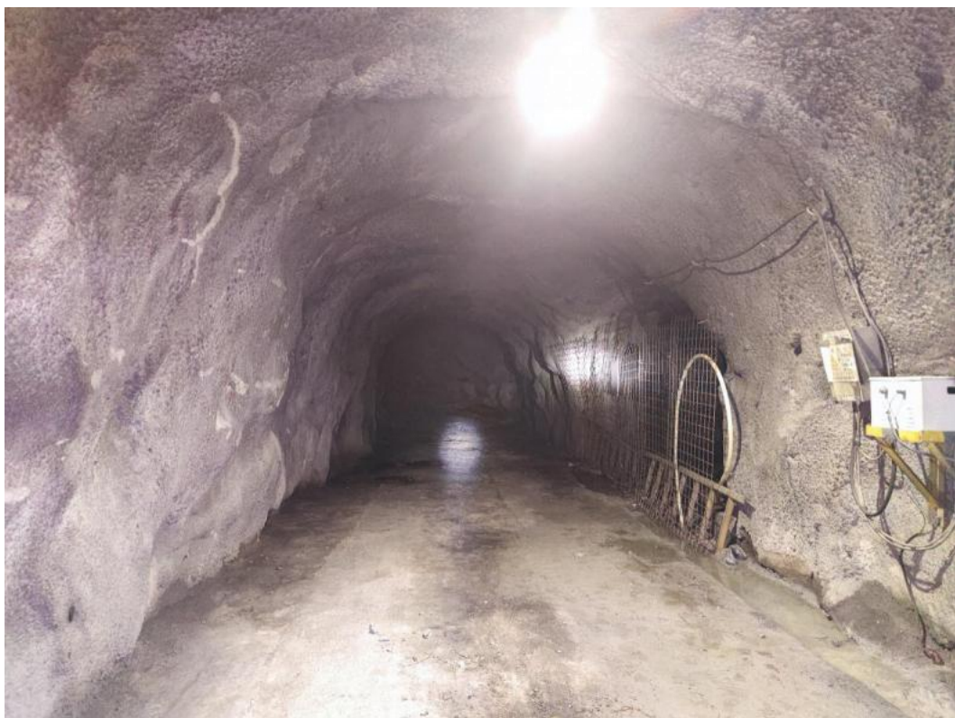
图 1 重新集铁矿原-470m 储油硐室已拆除
