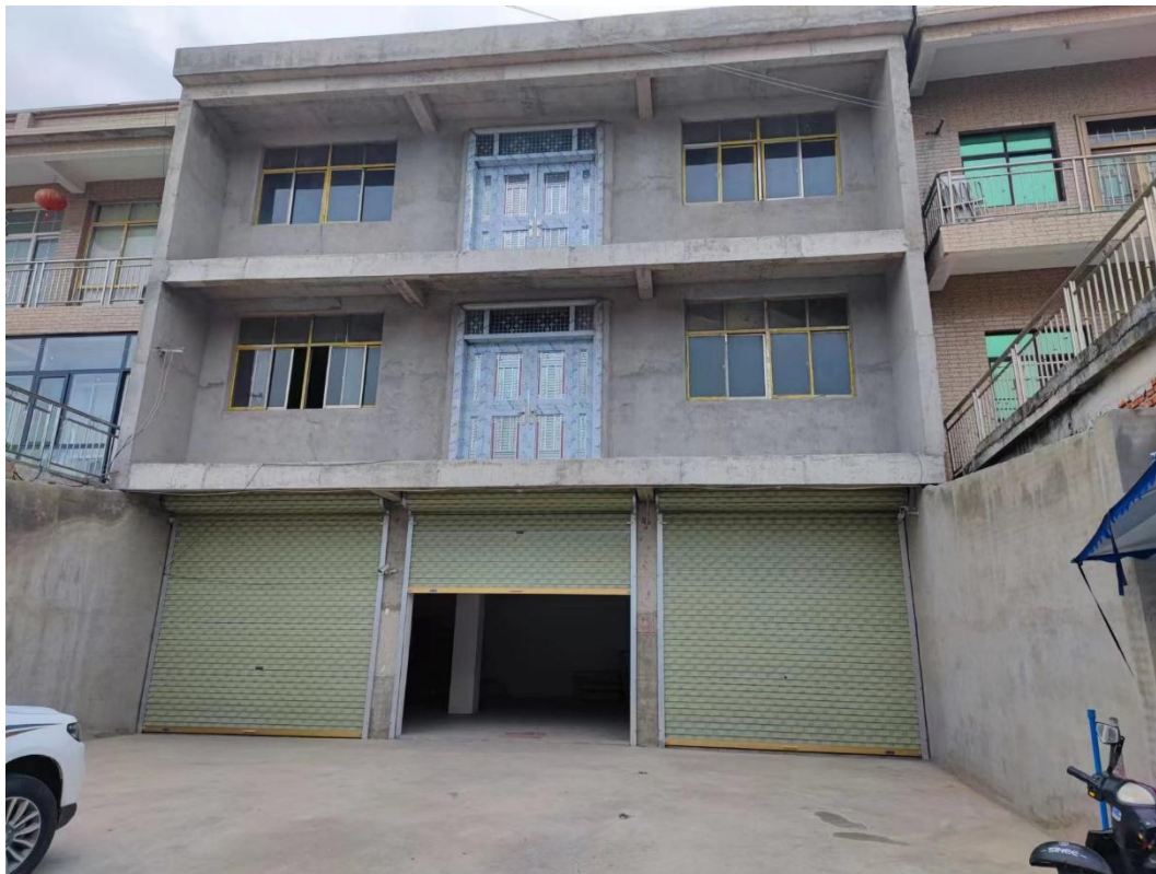
图 1 原事故发生建筑现状
