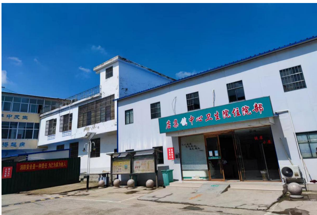
图 1 店集镇卫生院住院部部分房屋窗户安装有防盗窗
