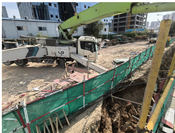
泵车停放位置
