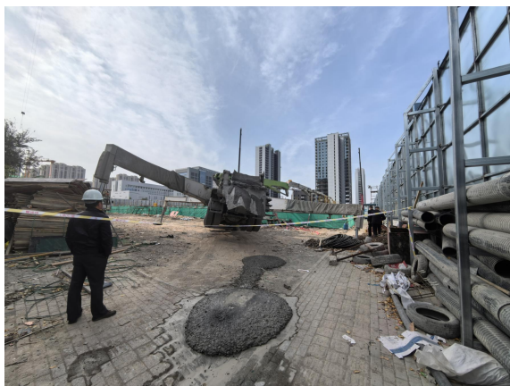
6 号楼东侧空地
