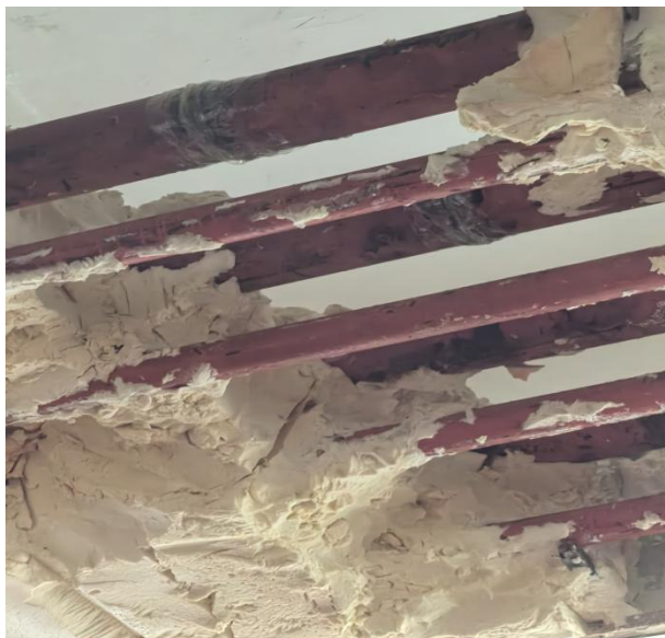
（管道焊缝开裂的泄漏点）
