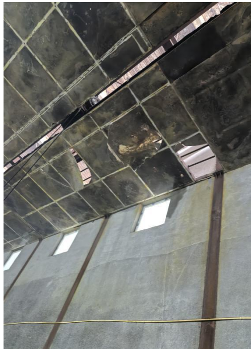
（顶棚方管结构下敷防腐板）
