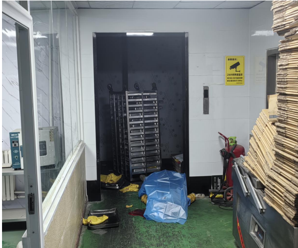
图 1 一楼事故现场
