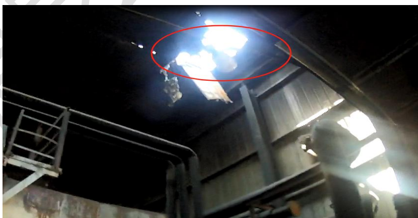
图 1：事故遇难者高处坠落房顶的位置。
