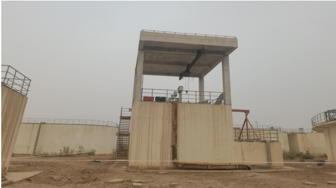
8 号中沉池污泥泵井外观图
