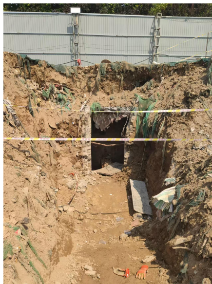
图7 侧面破开井壁的救援通道
