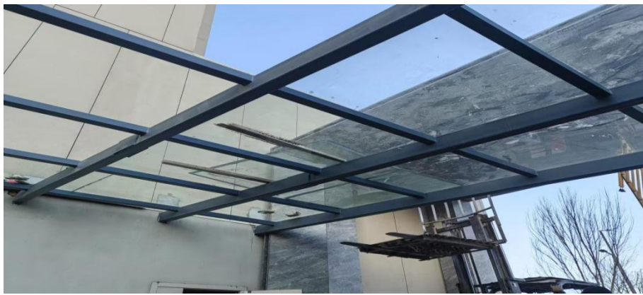
图 4：在雨棚下观察雨棚西北角处叉车及玻璃安装、摆放情况
