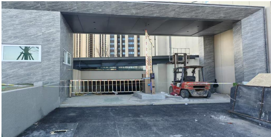
图 2：在车库出入口外由北向南观察车库通道口处情况
