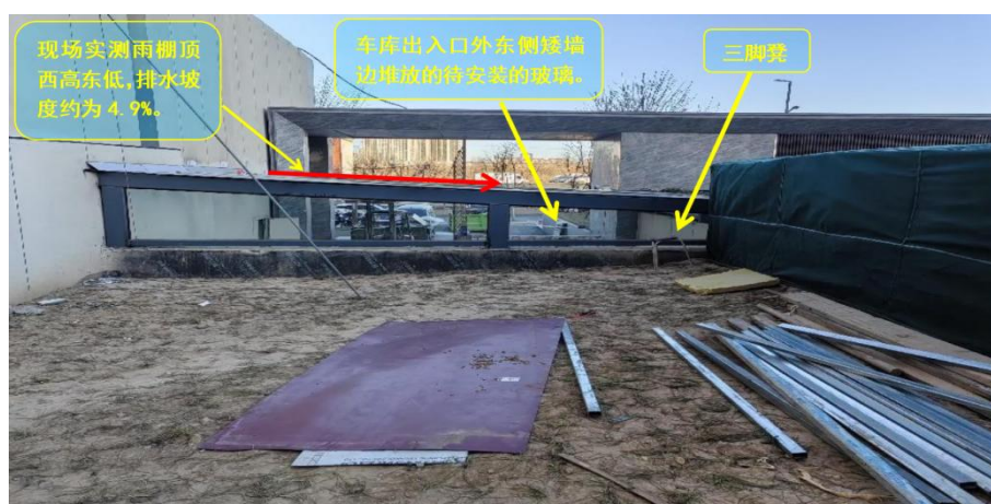
图 9：从雨棚下由东北向西南观察雨棚顶部玻璃安装情况及车库坡道地面情况
