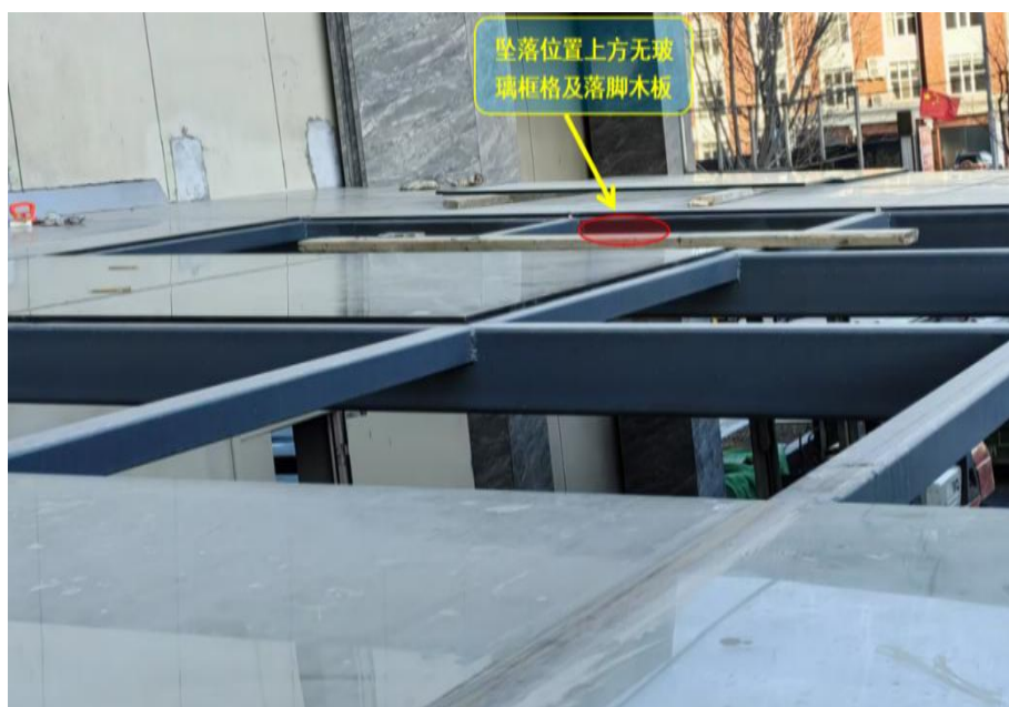
图 6：从雨棚顶外由东向西观察雨棚顶部玻璃安装情况及车库坡道地面情况
