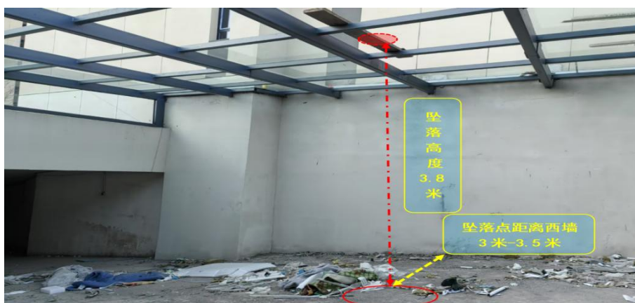
图 8：从雨棚下由东北向西南观察雨棚顶部玻璃安装情况及车库坡道地面情况
