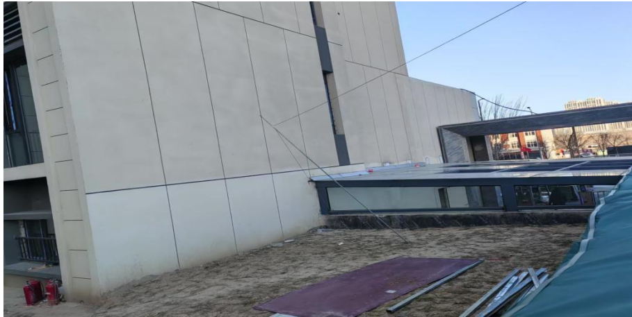
图 10：钢结构玻璃雨棚顶外南侧架设的临时用电线路
