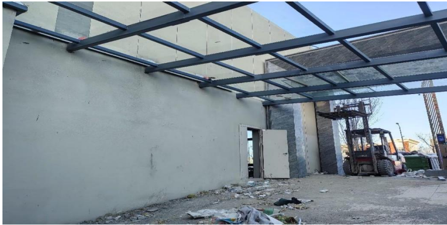
图 3：在车库出入口处雨棚下由南向北观察车库出入口处情况
