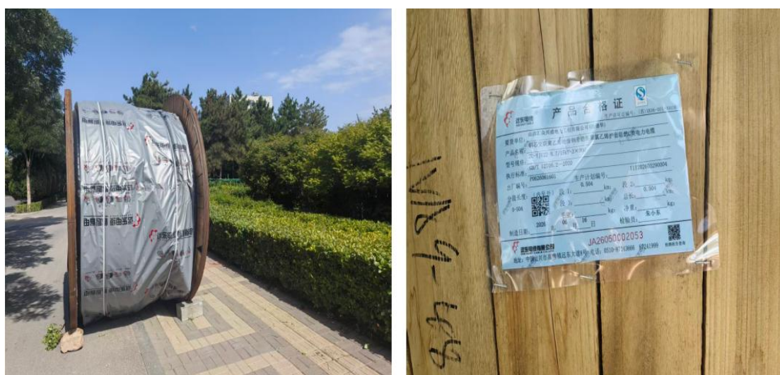
图 19 事故现场东侧摆放的电缆盘及其产品合格证
