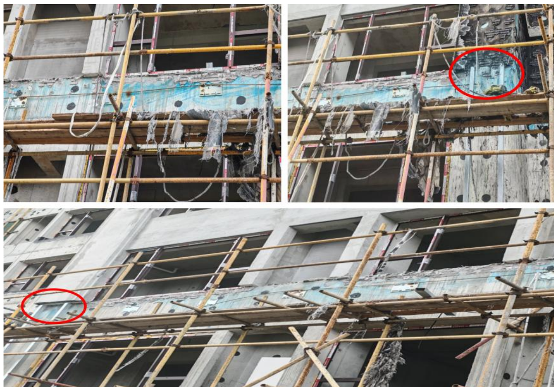
图 4: 1、2 层阳台东西两侧边缘各 2 根竖直的镀锌方管
