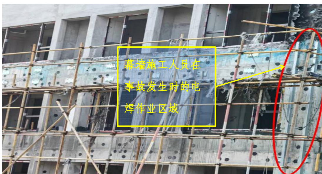
图 3：幕墙施工人员在事故发生时的电焊作业区域
